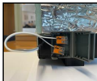
3 _chiudere le levette dei terminali, appoggiarli al gel dell'alloggiamento e chiudere la cassetina. 3_ close the levers of the terminals, place them on the housing's gel and close the housing.
